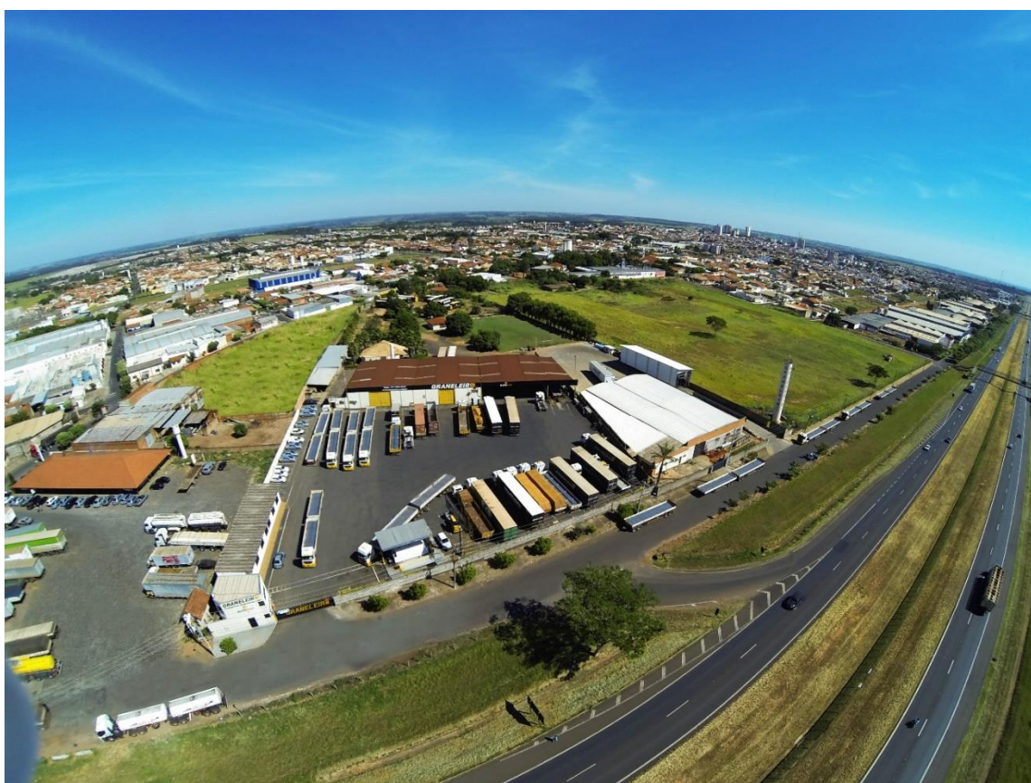
Figura 1 – Sede Administrativa da RECUPERANDA
